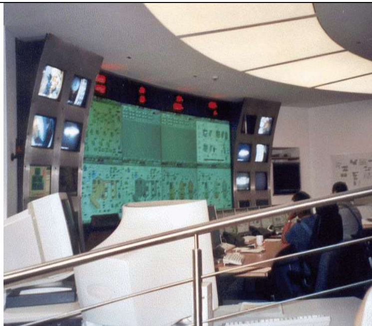
Fig.5 – A sala de controle da Usina operada pela queima do lixo da cidade. São aproveitados 60 MW de energia térmica.
