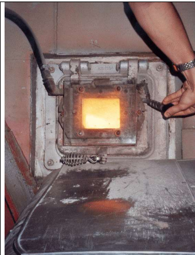
Fig.2 – Uma janela onde se vê o lixo queimando e produzindo a energia para o aquecimento de água e ambientes de Viena, através de mais de 900km de tubulação.
