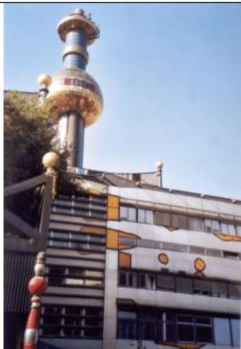
Fig.4 – Outra vista da chaminé com o prédio da administração.
